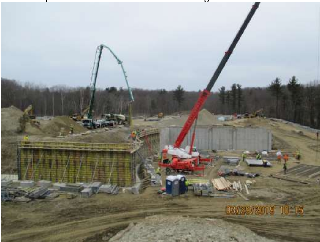
2. Foundation wall pour
